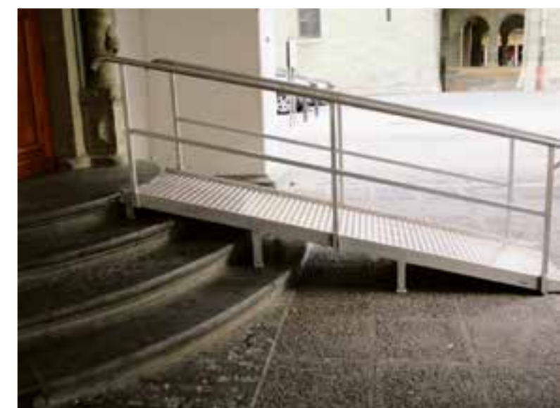
Schildbürgerstreich am „Blauen Saal“: Eine deutlich zu steile Rampe.
