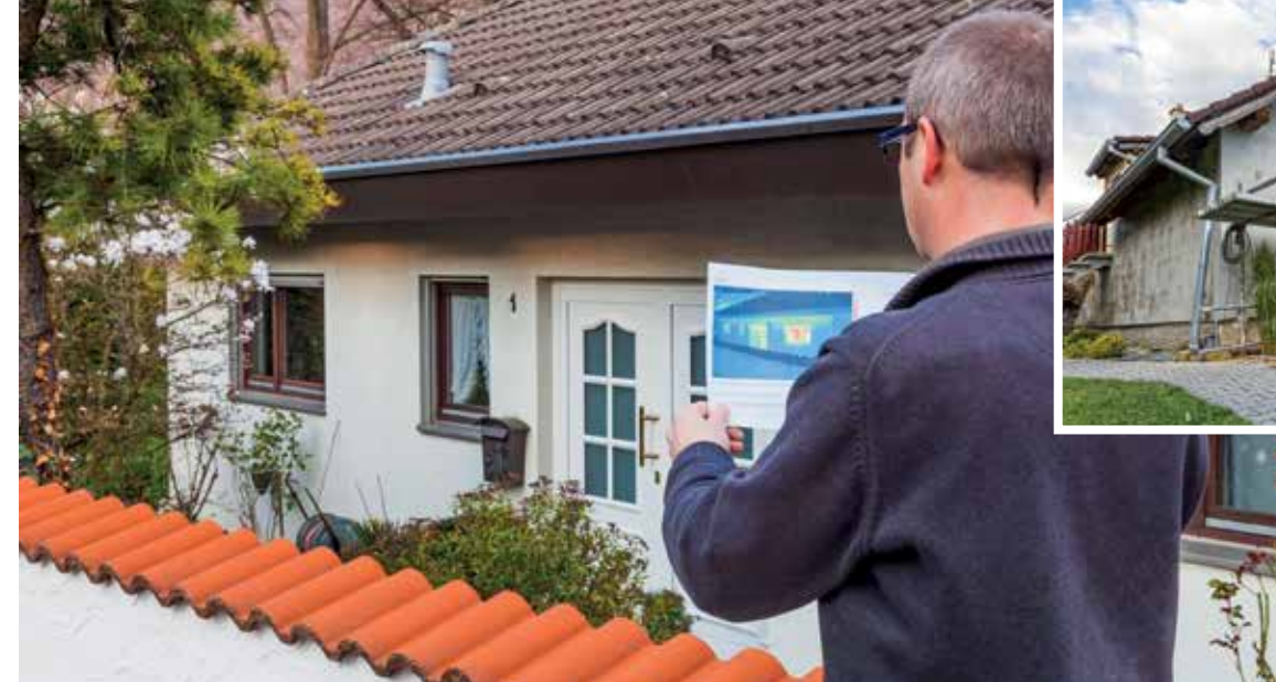
Eine Untersuchung mit der Wärmebildkamera bringt energetische Schwachstellen des Eigenheims ans Licht. Energieberater und Fachhandwerker helfen bei der individuellen Sanierungsplanung. Foto: djd/Qualitätsgedämmte.V./Getty
