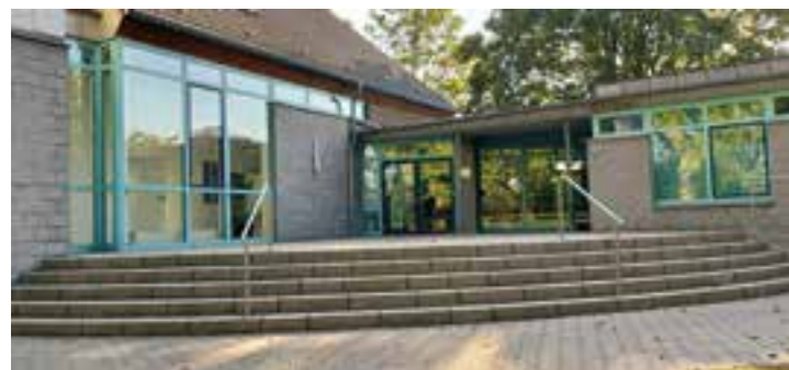
Das Jakobus Gemeindehaus ist neben Treppenstufen auch mit einer Rampe für alle Rollstuhl- und Rollatorenfahrer*innen barrierefrei zu allen Veranstaltungen erreichbar. Fotos: Seniorenbüro Brackel
