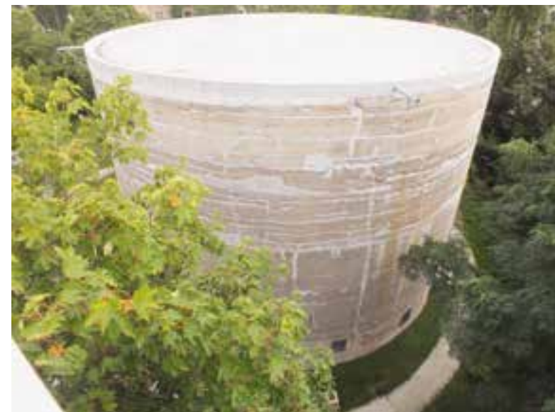
Zylinder aus 12.500 Tonnen schierem Beton.
